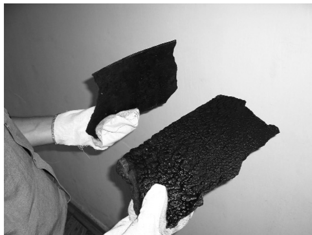
Рис. 1. Железоокисные отложения с головки деаэратора
