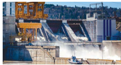
Павловская ГЭС в пик паводка
